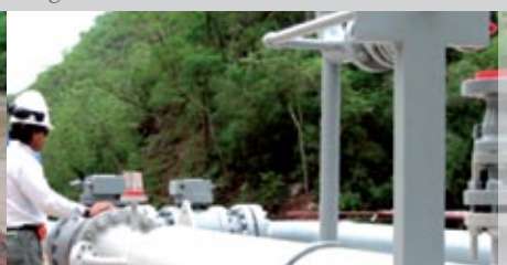
Ductos de Agua en PEAD Y ERFV. Yacimiento Planta El Sábalo. Bolivia.
