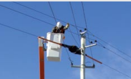
Servicio de Trabajo con Tensión en Líneas Aéreas de Media Tensión. Cerro Dragón. Chubut - Pan American Energy.
