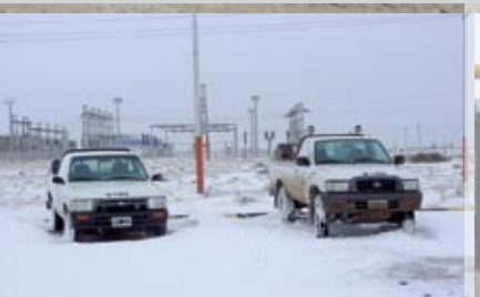
Mantenimiento Eléctrico Integral de Yacimiento. Los Perales / Las Heras / Cañadón Seco, Santa Cruz - YPF.
