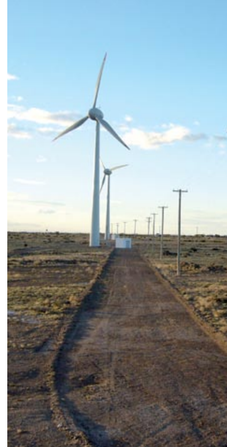
Montaje Obra Eléctrica Parque Eólico PT. Pico Truncado - Santa Cruz - WOBLEN WINDPOWER
