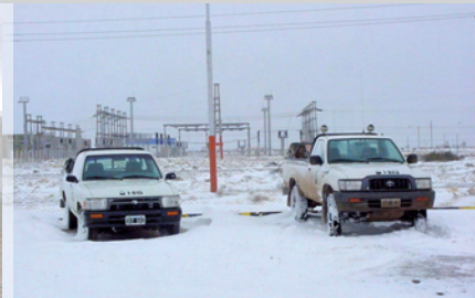
Mantenimiento Eléctrico Integral de Yacimiento. Los Perales / Las Heras / Cañadón Seco. Santa Cruz - YPF.
