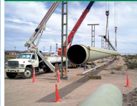
MONTAJE ANTORCHA. El Portón. Neuquén - REPSOL YPF.
